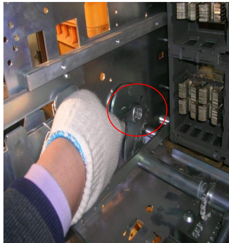
8. Чтобы извлечь боковые держатели слева и справа открутите 2 шурупа
